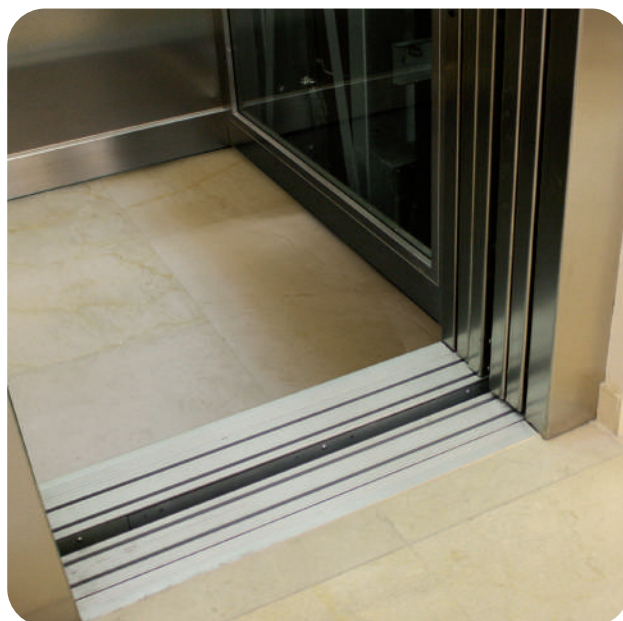
Plancher de la cabine
